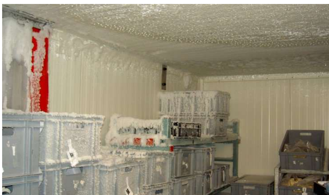
Figura 2.16 – Formação de gelo devido à umidade do ar Fonte: website – www.munters.com
