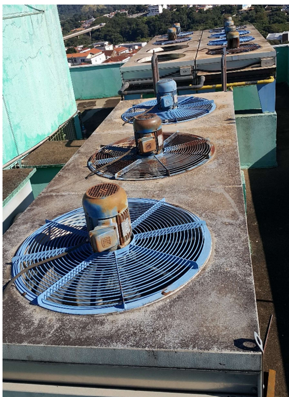
Figura 3.4 – Condensadores do supermercado
