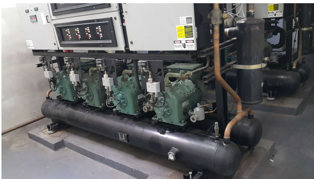
Figura 3.3 – Racks de refrigeração do supermercado
